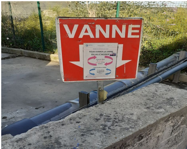
Vanne de barrage du réseau de collecte
