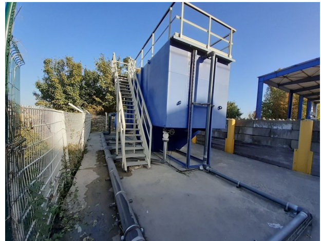
Décanteur du réseau de collecte
